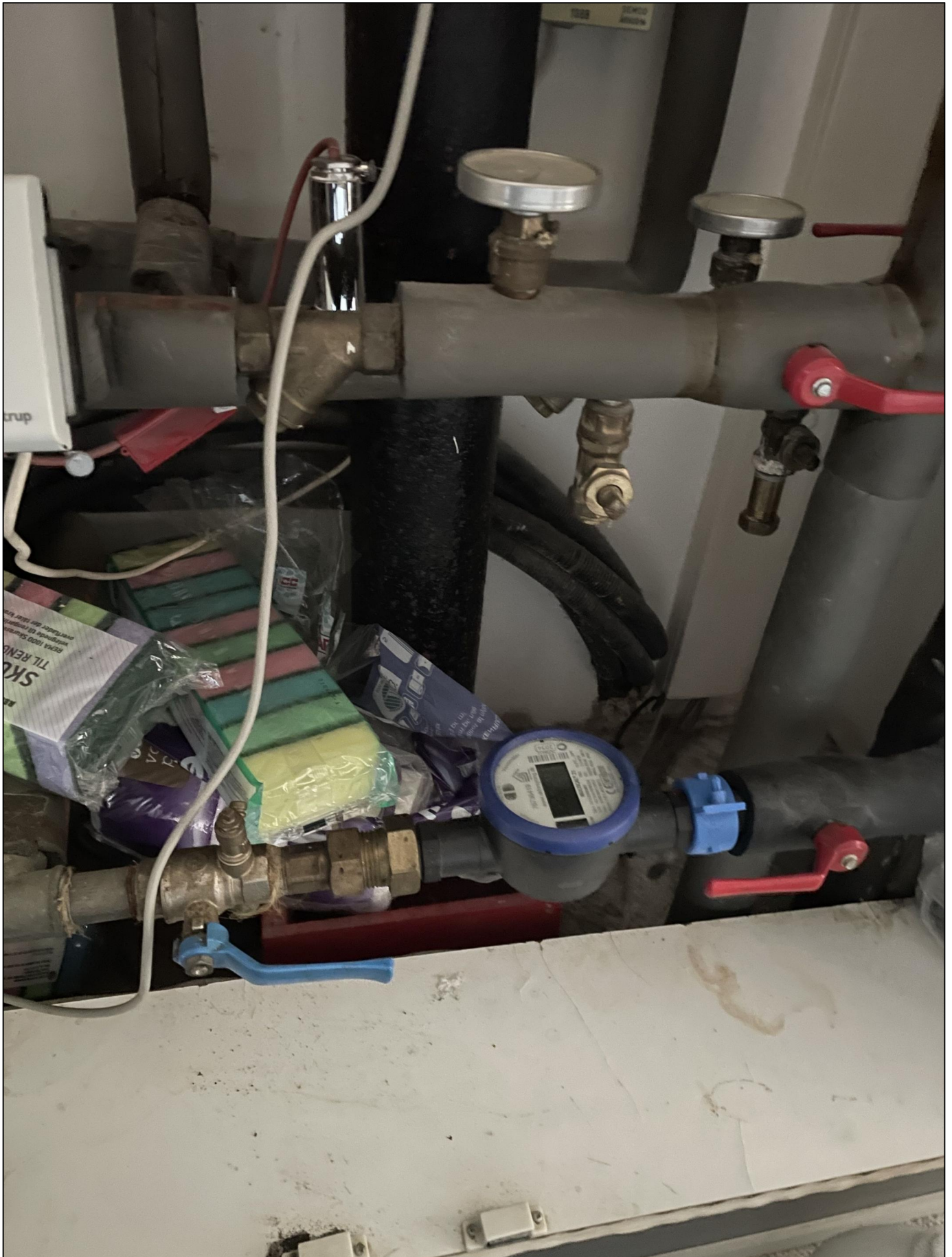
Defekt stophane efter måler.
